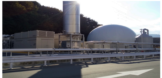
3週間、34mのメタン発酵槽で上下にしてガスに
